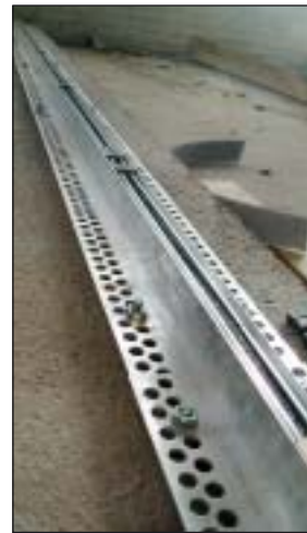
DEFLEX-profiilien metalliosat toimitetaan työmaalle 3-4 metrisinä kankina. Jousto-osa voidaan toimittaa jopa 20 metrisinä rullina, jolloin jatkoksia tulee mahdollisimman vähän.
