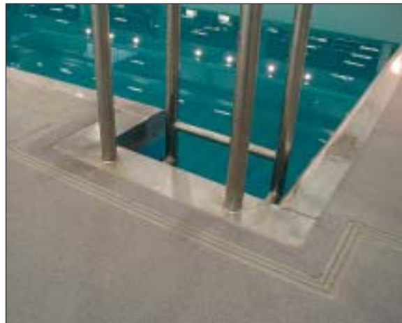
Risteys- ja kulmakohdista saadaan siistit, kun ne toimitetaan työmaalle valmiiksi mittojen mukaan tehtyinä kokonaisuuksina.
