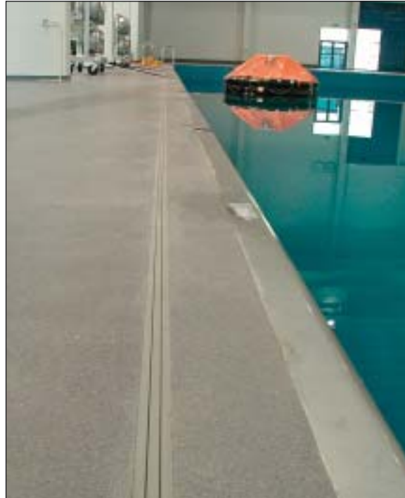
Leveämpi saumaprofiilin jousto-osa kestää repeämättä suuremmatkin liikkeet.
