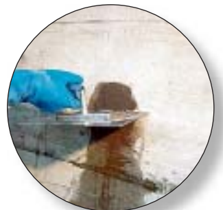
Vandex Plug kovettuu n. 30 sekunnissa. Anna massan saavuttaa sopiva lujuus ja poista ylimääräinen aine pois.
