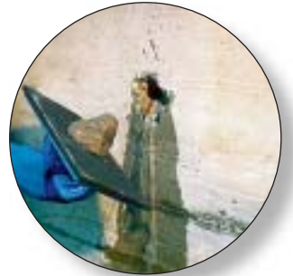
Sekoita kerralla käytettävä määrä Vandex Plugia ja tee massasta vuotokohtaan sopiva pallo
