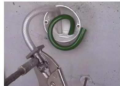
Käytettäessä kahta eri väristä syöttöletkua injektointiletkujen eri päissä, on letkujen sisään- ja ulosmenot helppo tunnistaa injektointia suoritettaessa.
